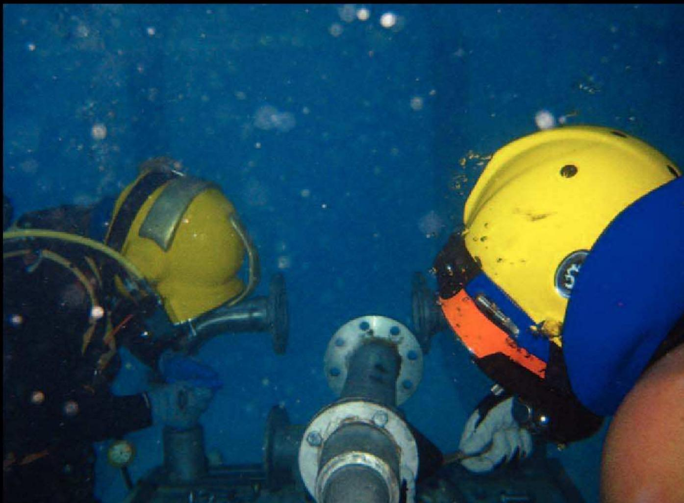
In apertura, elmetto professionale Kirby Morgan, agganciato all'ombelicale, per una immersione *surface*. Qui sopra due allievi del Cedifop, impegnati in una operazione di flangiatura. L'uso dell'erogatore è assolutamente contrario ai criteri di sicurezza, anche se l'immersione è in pochi metri d'acqua
